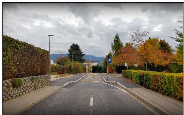
arrêt de bus au milieu de la chaussée avec rétrécissement de la voie de circulation. Cette modification a permis non seulement d'avoir une continuité avec la route des Martinets, mais aussi d'augmenter la sécurité du passage piéton. Cette solution empêche les automobilistes d'effectuer un dépassement illicite du bus à l'arrêt et ainsi mettre en danger des enfants qui traversent la route sur le passage piétons.
