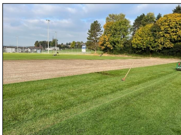
Réfection terrain principal du Platy (Phase travaux)
