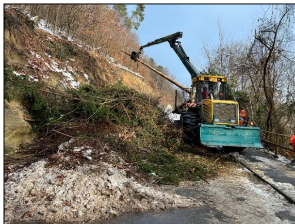
Nettoyage de la falaise à la route du Vieux-Moulin
