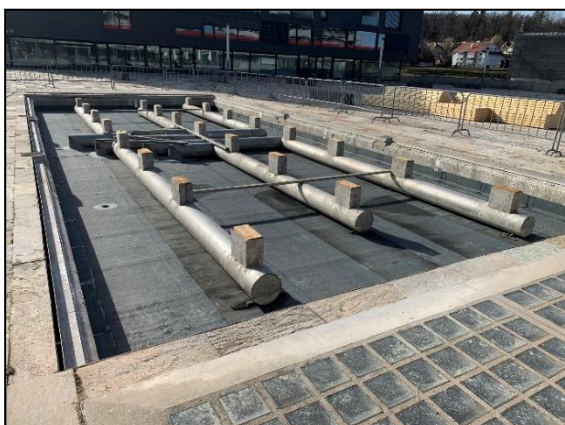
Fontaine de Cormanon (Phase travaux)
