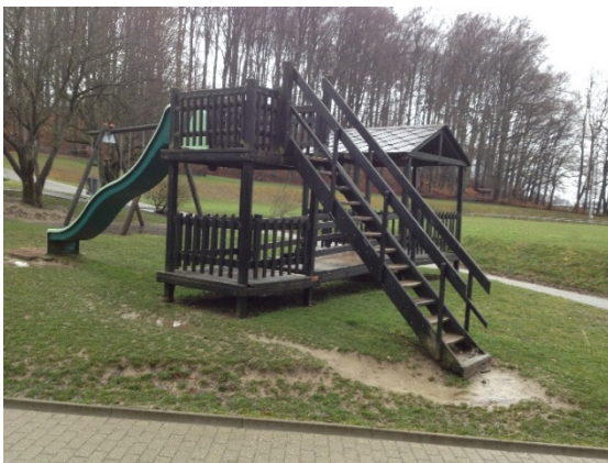
Situation avant les travaux
