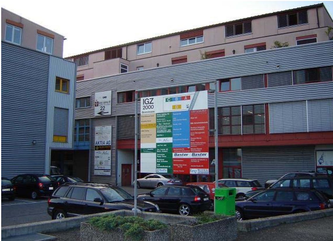
Panneau d'entrée du site de Guin)
