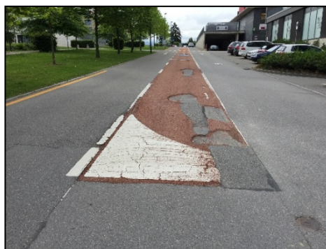
Réfection bande rouge –Route du Centre
