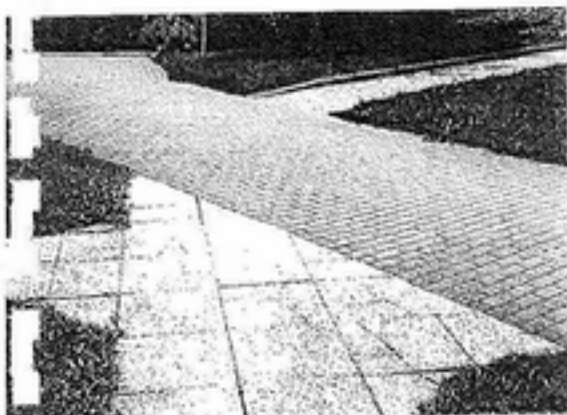
Revêtements de sol conçus avec un trop grand nombre de matériaux différents
