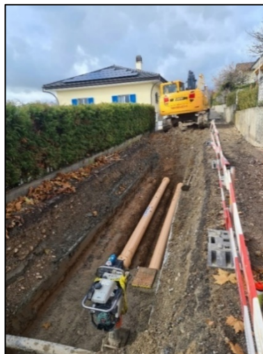
Mise en séparatif du quartier du Pré de l'Etang
