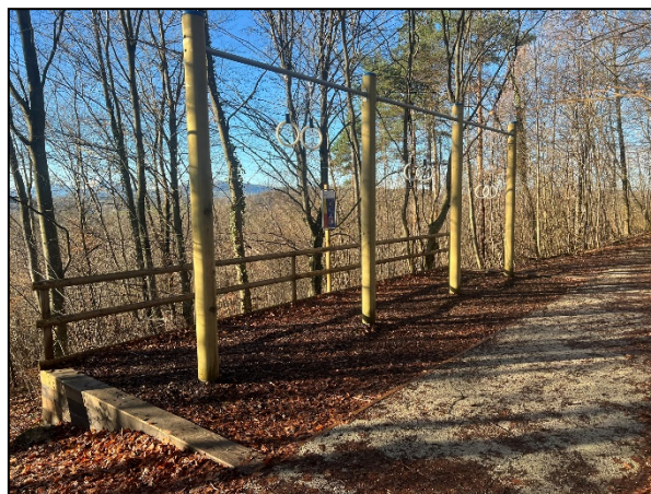
Remplacement poste parcours Vita - Platy
