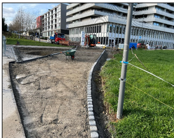
Adaptation cheminement existant – Parc urbain de Cormanon
