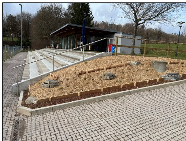
Aménagements extérieurs Centre Sportif du Platy
