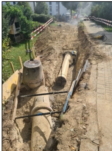
Pose d'un nouveau collecteur
