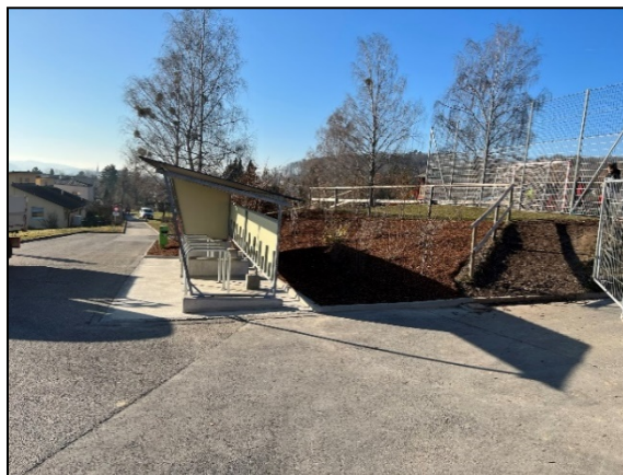
Aménagements extérieurs école de Cormanon
