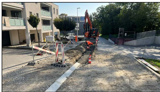
Travaux de réfection chemin de Bel-Air
