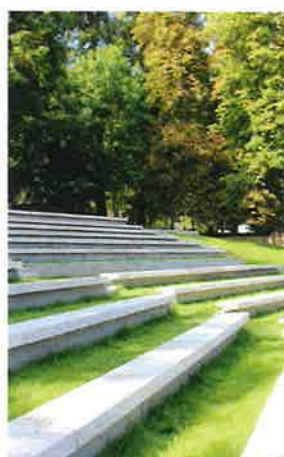
Gradins plantés en béton préfabriqués
