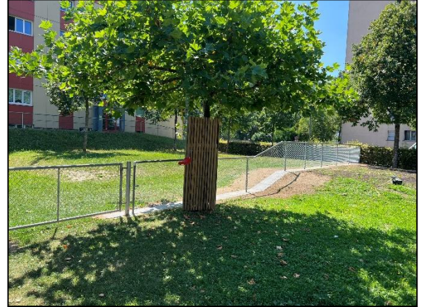
Travaux de sécurisation autour du bâtiment Le Milieu – Villars-Vert
