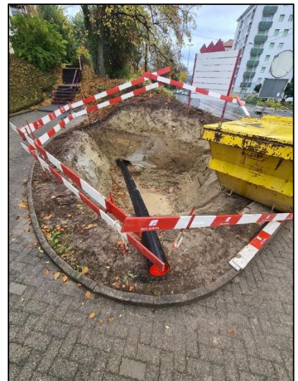
Forage dirigé du nouveau collecteur d'eau pluviale à la Redoute
