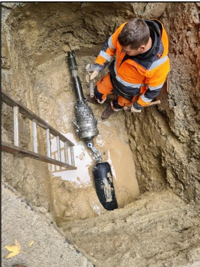
Forage dirigé du nouveau collecteur d'eau pluviale à la Redoute
