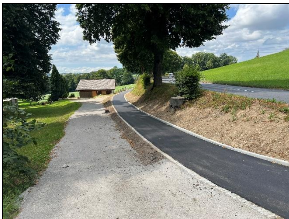
Réfection trottoir – Route du Condoz
