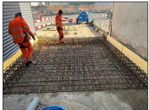
Réalisation fondation pour le nouv. silo à saumure
